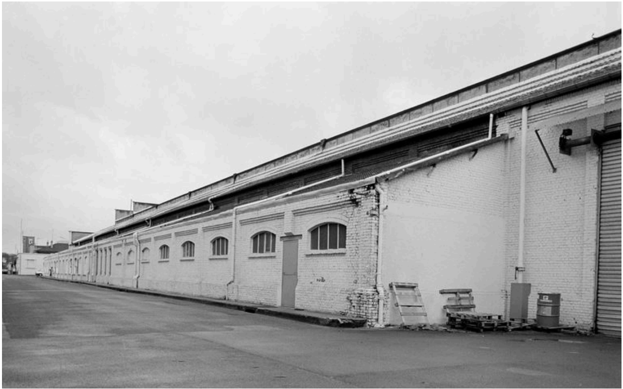
Atelier de fabrication principal : flanc sud.
