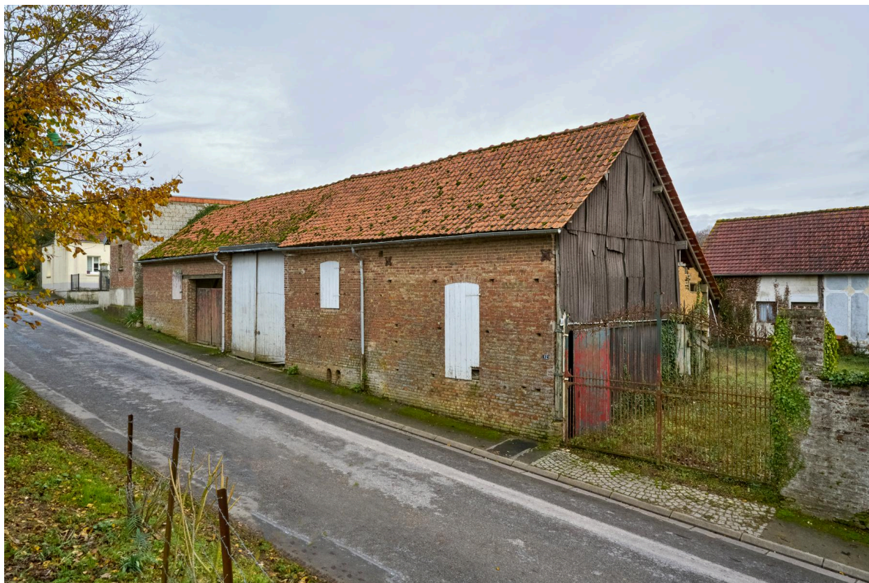
Bâtiment ouest, depuis la rue.
