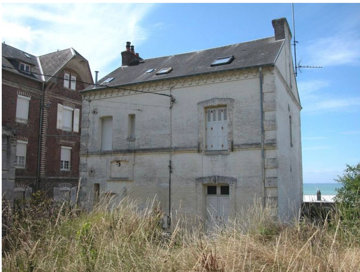
Elévation postérieure depuis la rue Gros.
