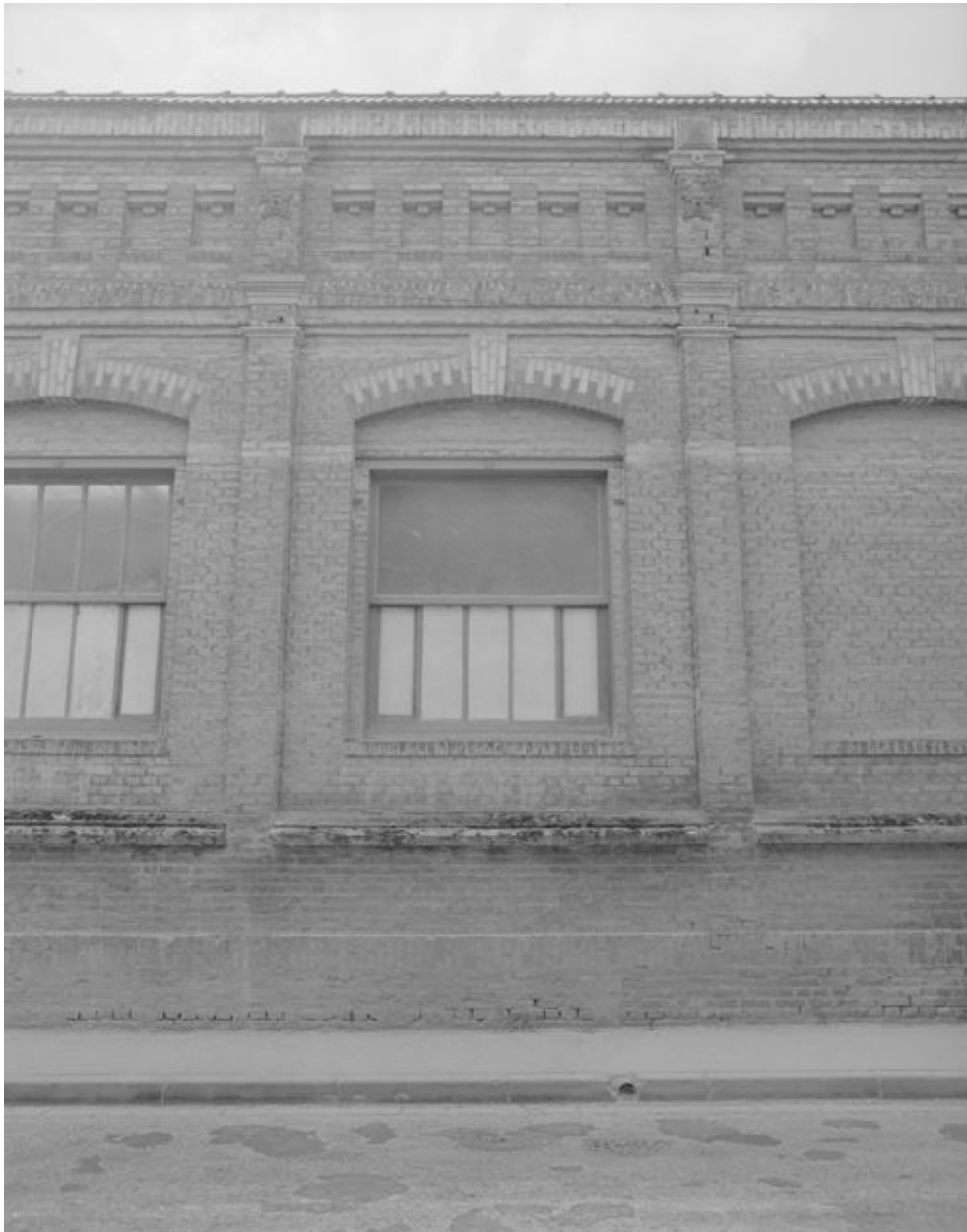
Atelier de fabrication, élévation antérieure.
