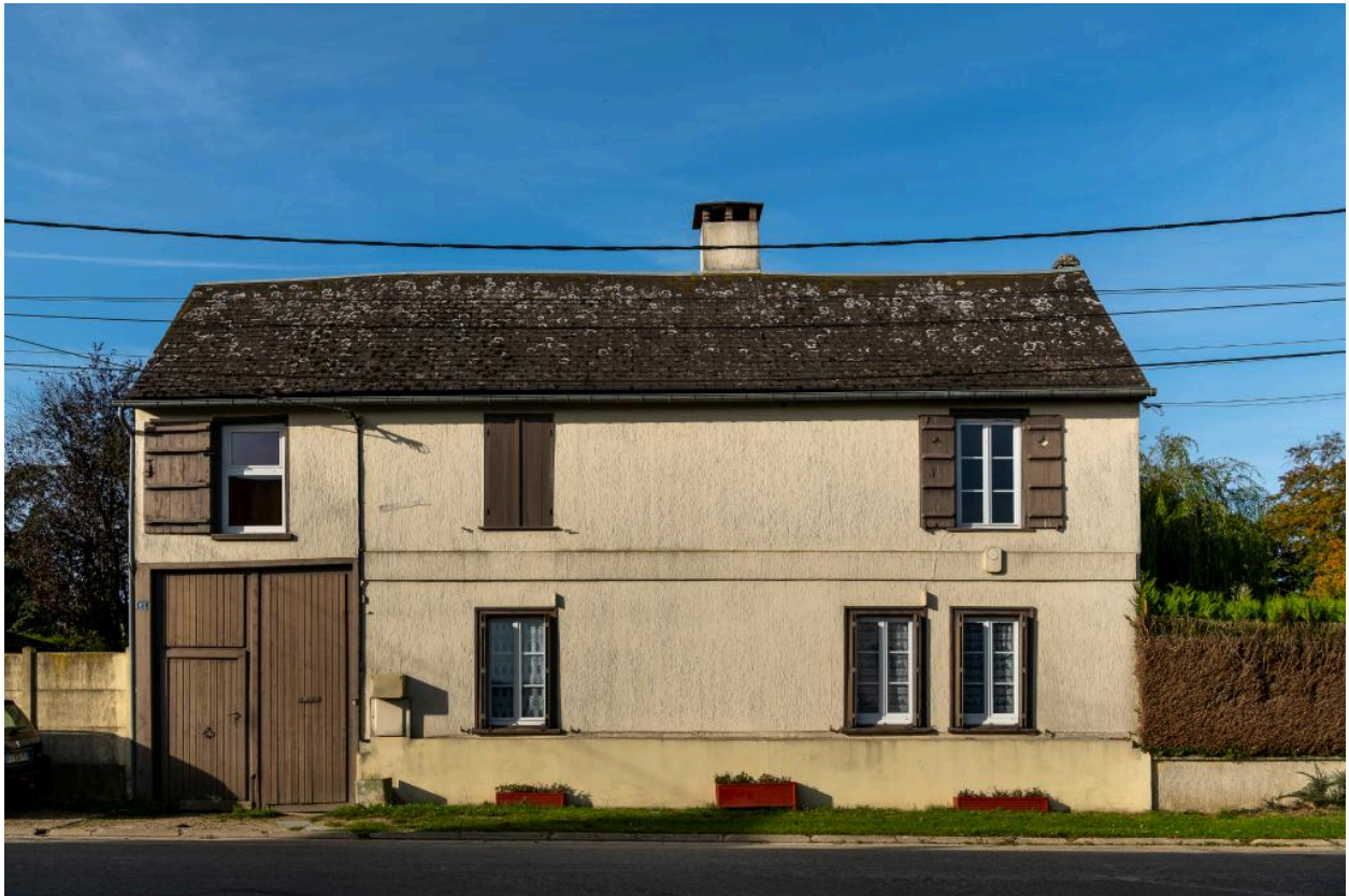
Ancienne maison de serger (?), n°61 rue Principale, vue depuis l'est.
