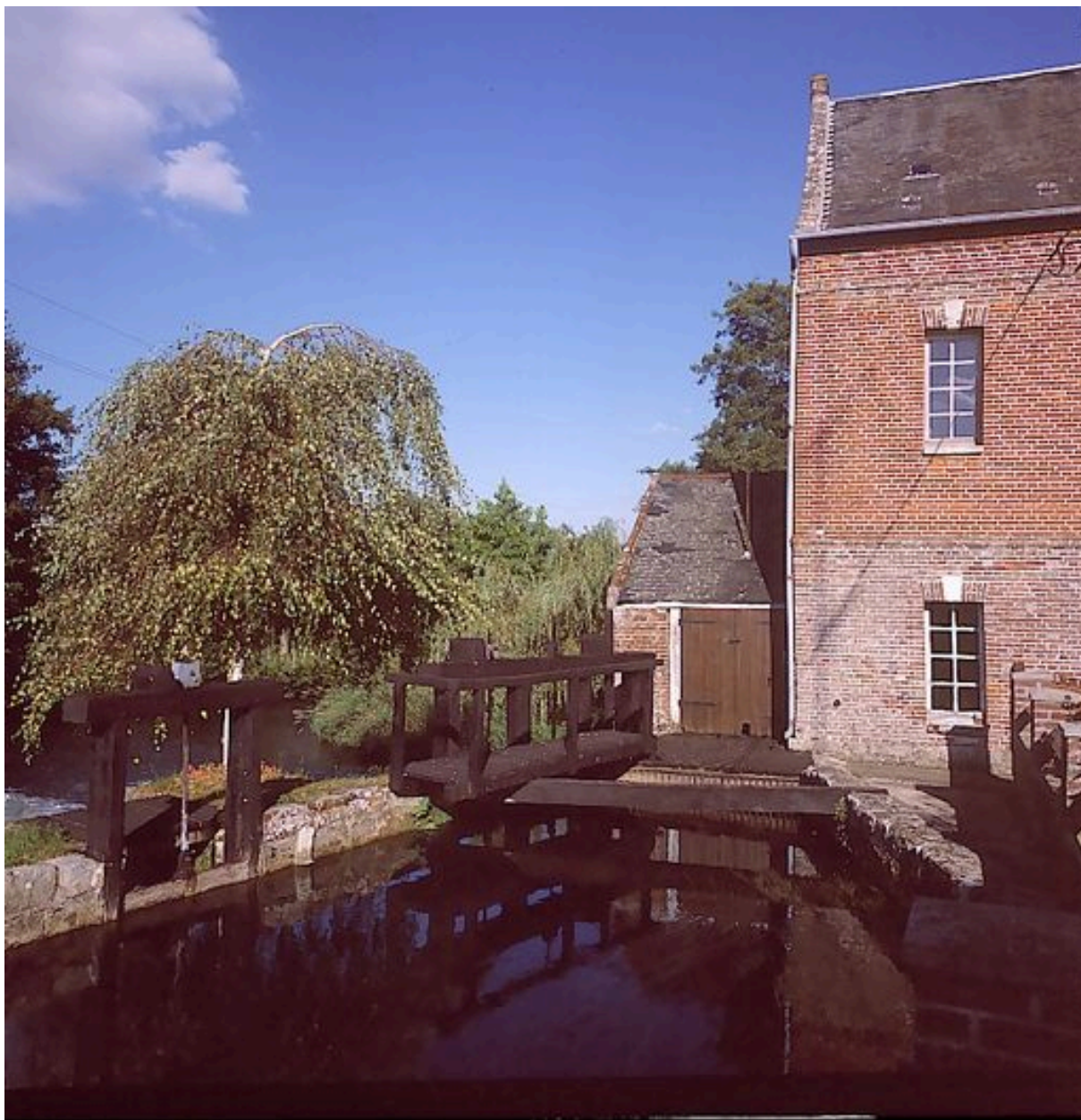
Vue du vannage et de la cage du moulin.
