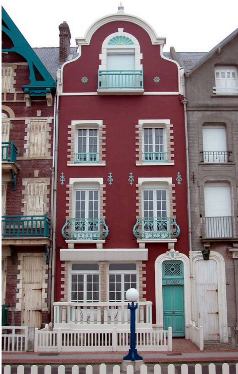
Vue d'ensemble de la maison dite Fantaisie.
