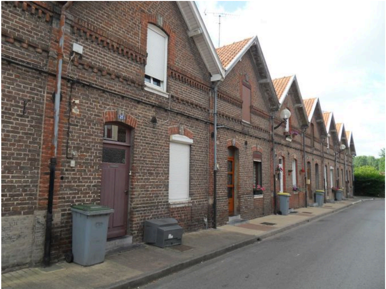
Vue des logements de la rive est (construits sur la commune de Bettencourt-Saint-Ouen).
