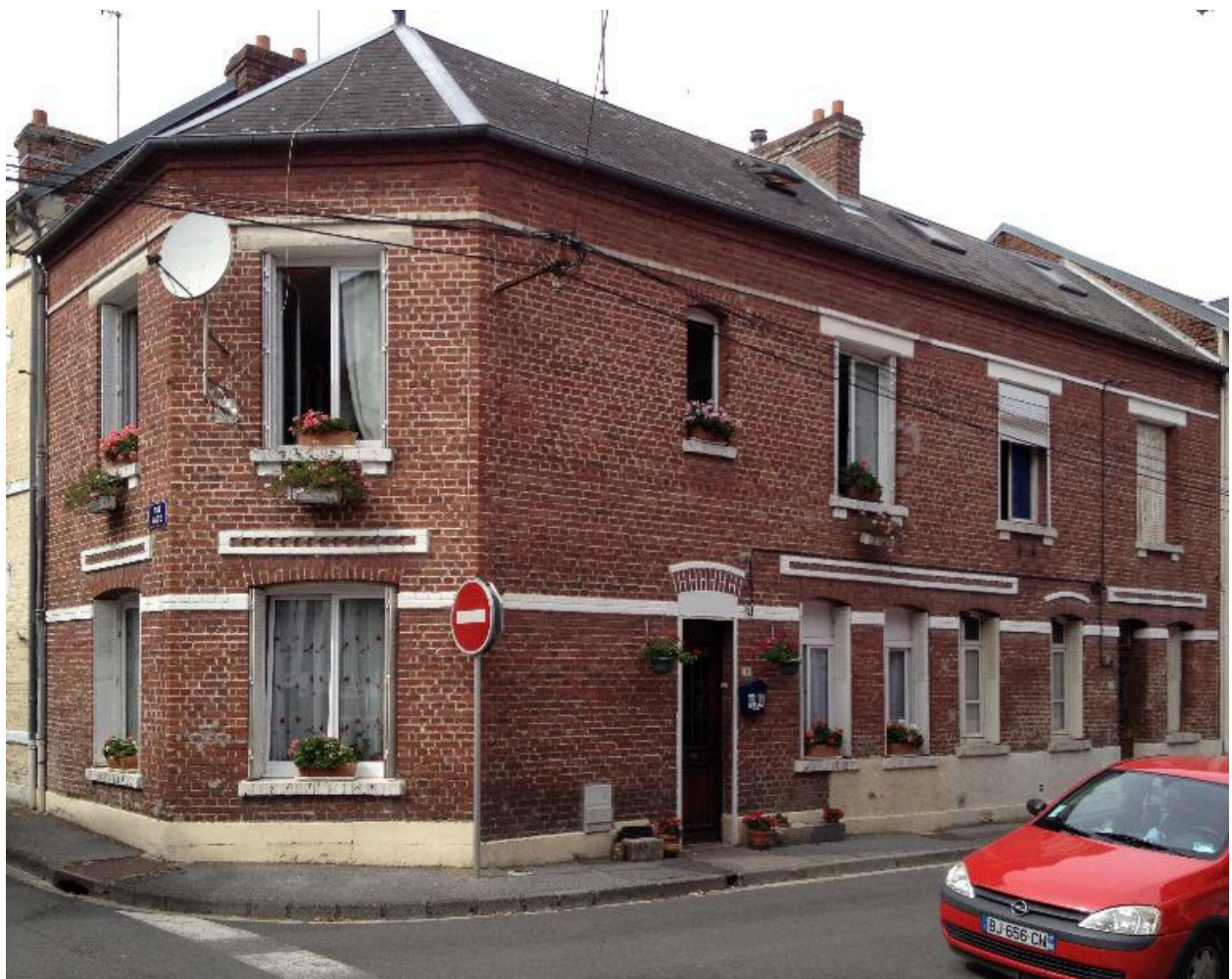
Maison d'angle, 7 et 9 rue du Grenier-à-sel.
