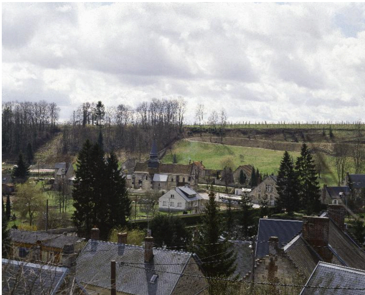
Vue du centre du village et du plateau sud, depuis le nord-ouest.
