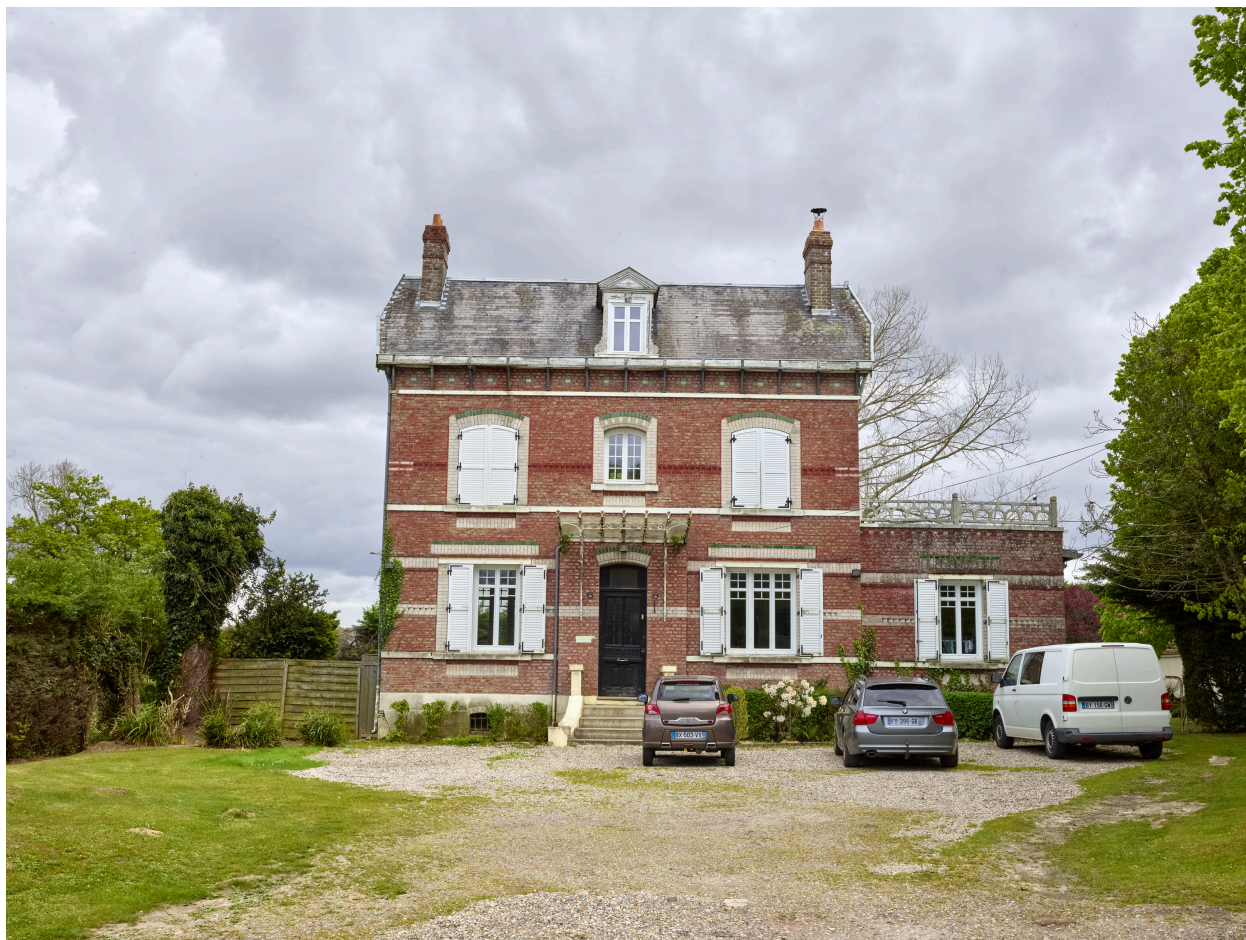
Vue de la maison depuis l'ouest.
