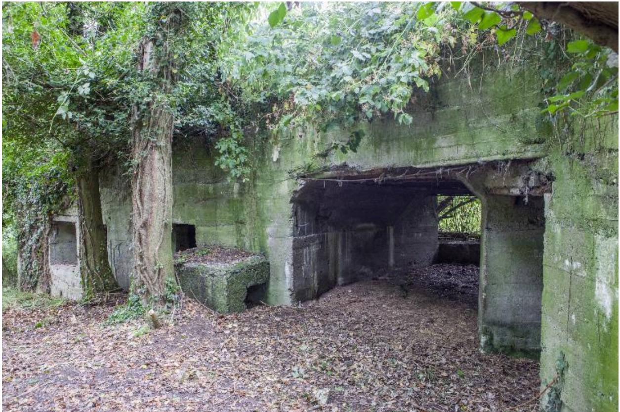
Chambre de tir en enfilade
