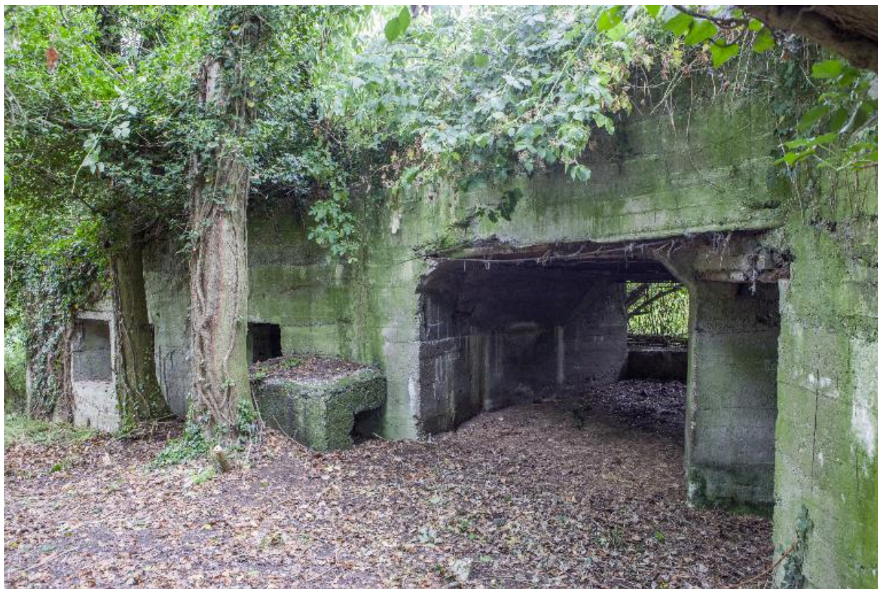
Chambre de tir en enfilade
