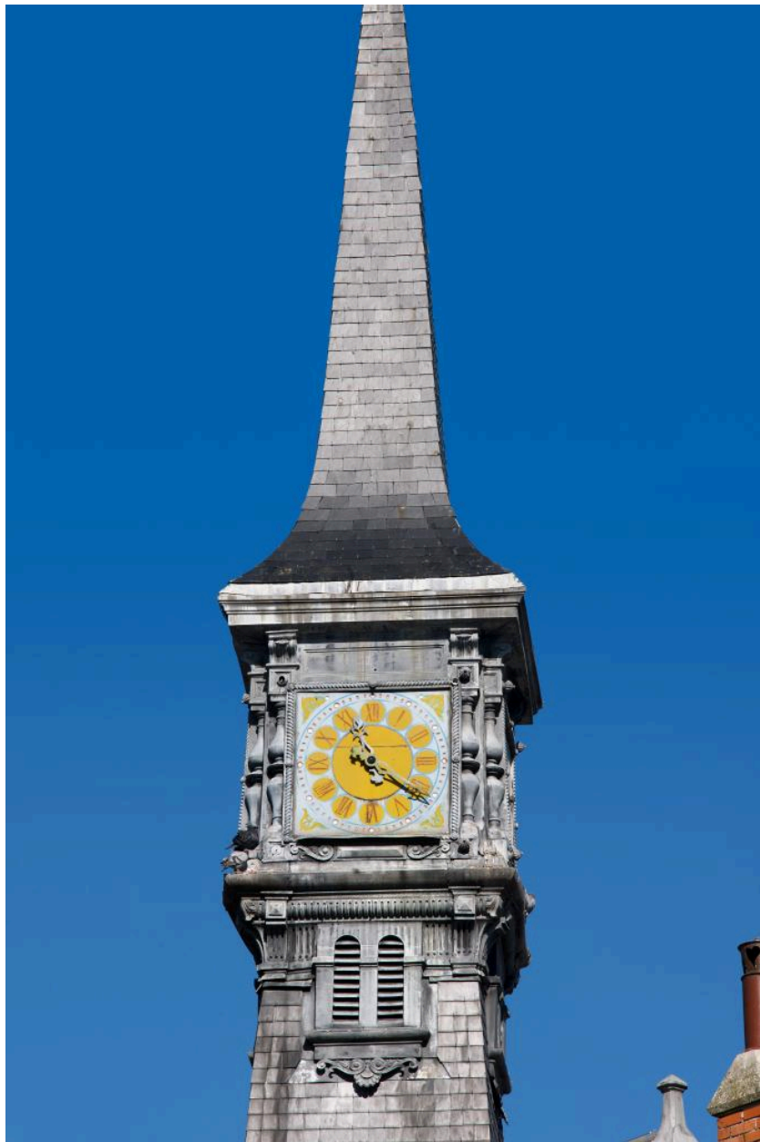
Détail de la flèche et de l'horloge de la gare.
