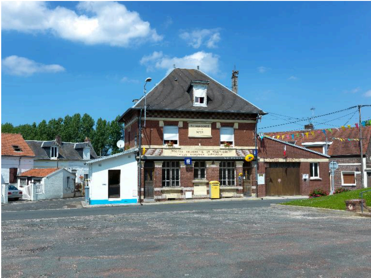
Vue générale depuis la place de l'Eglise.
