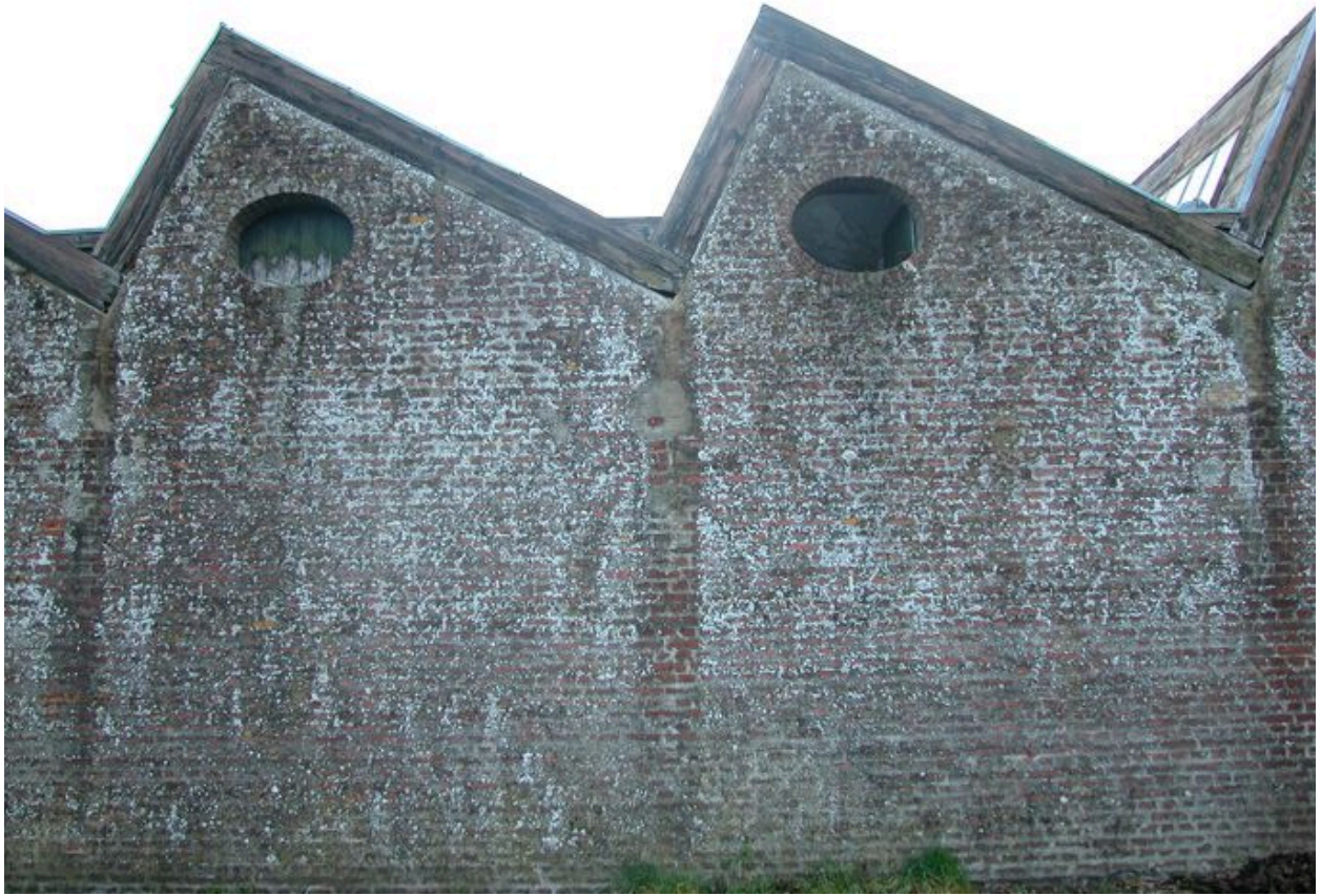
Détail des sheds des ateliers sur rue, vue de face.
