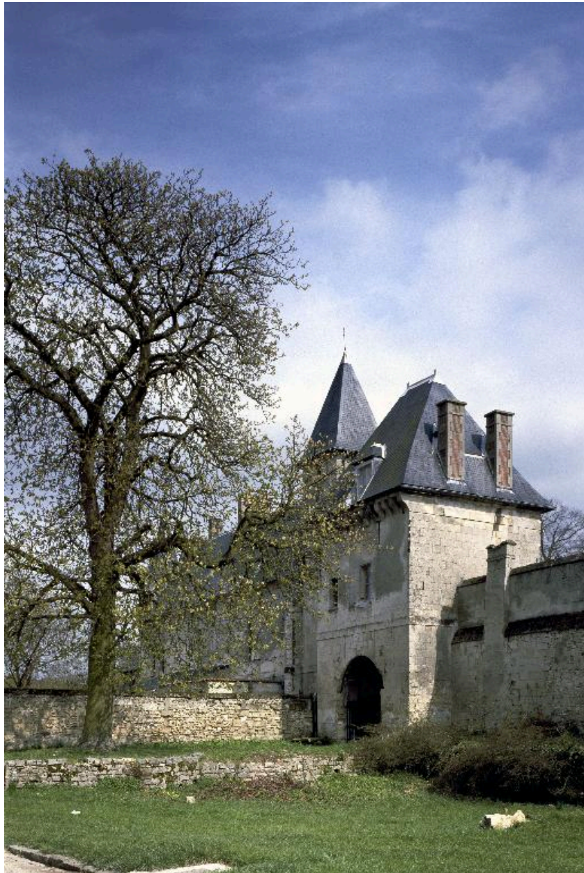
Vue extérieure de l'ouvrage d'entrée, depuis l'ouest.
