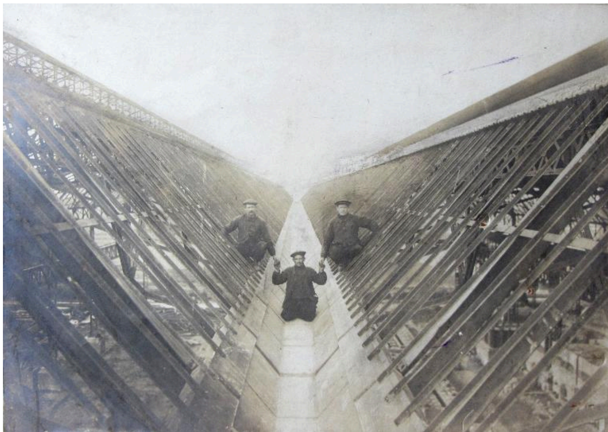
La construction de la charpente métallique des ateliers de l'usine, 1922 (coll. part.).
