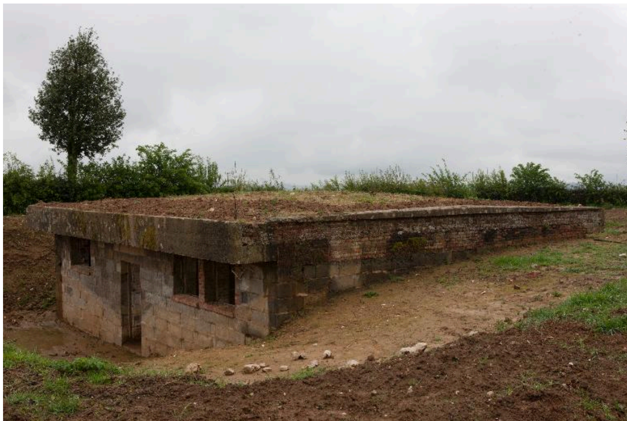
Abri casernement : vue postérieure.
