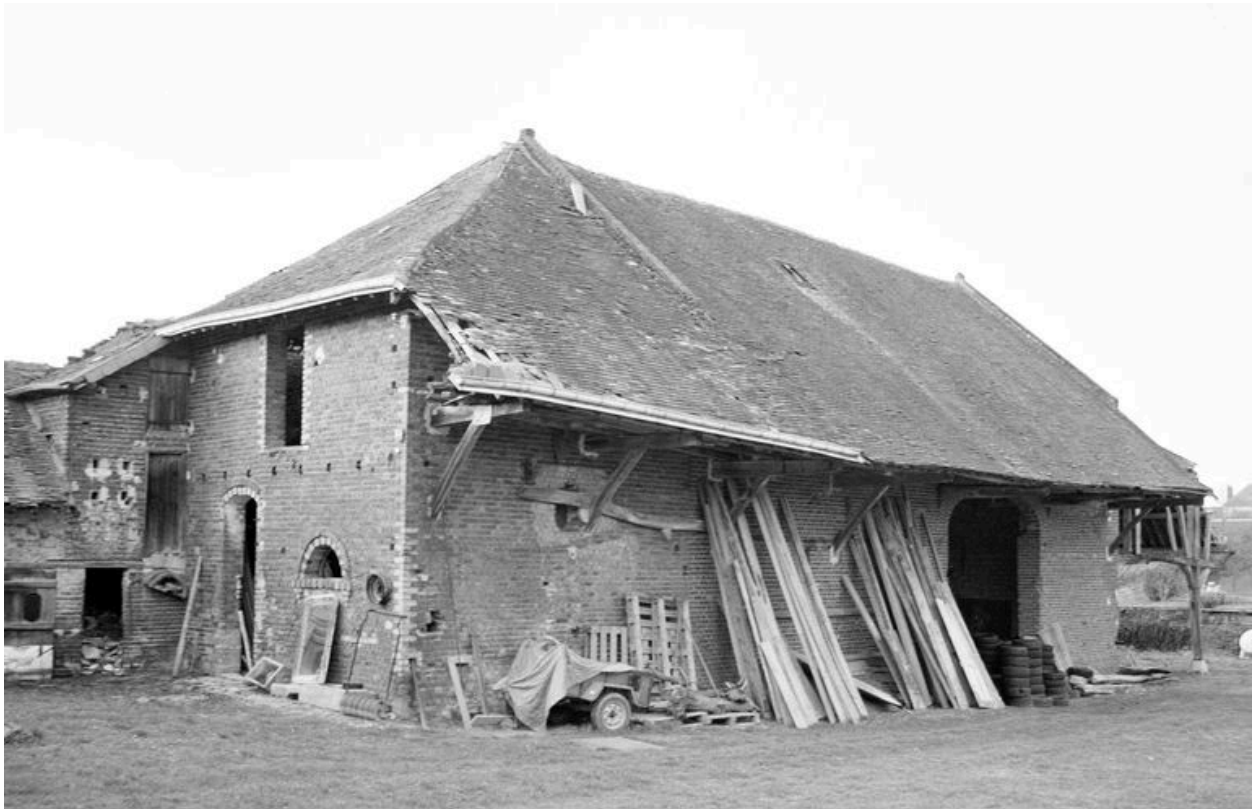
Grange : façade sur cour.
