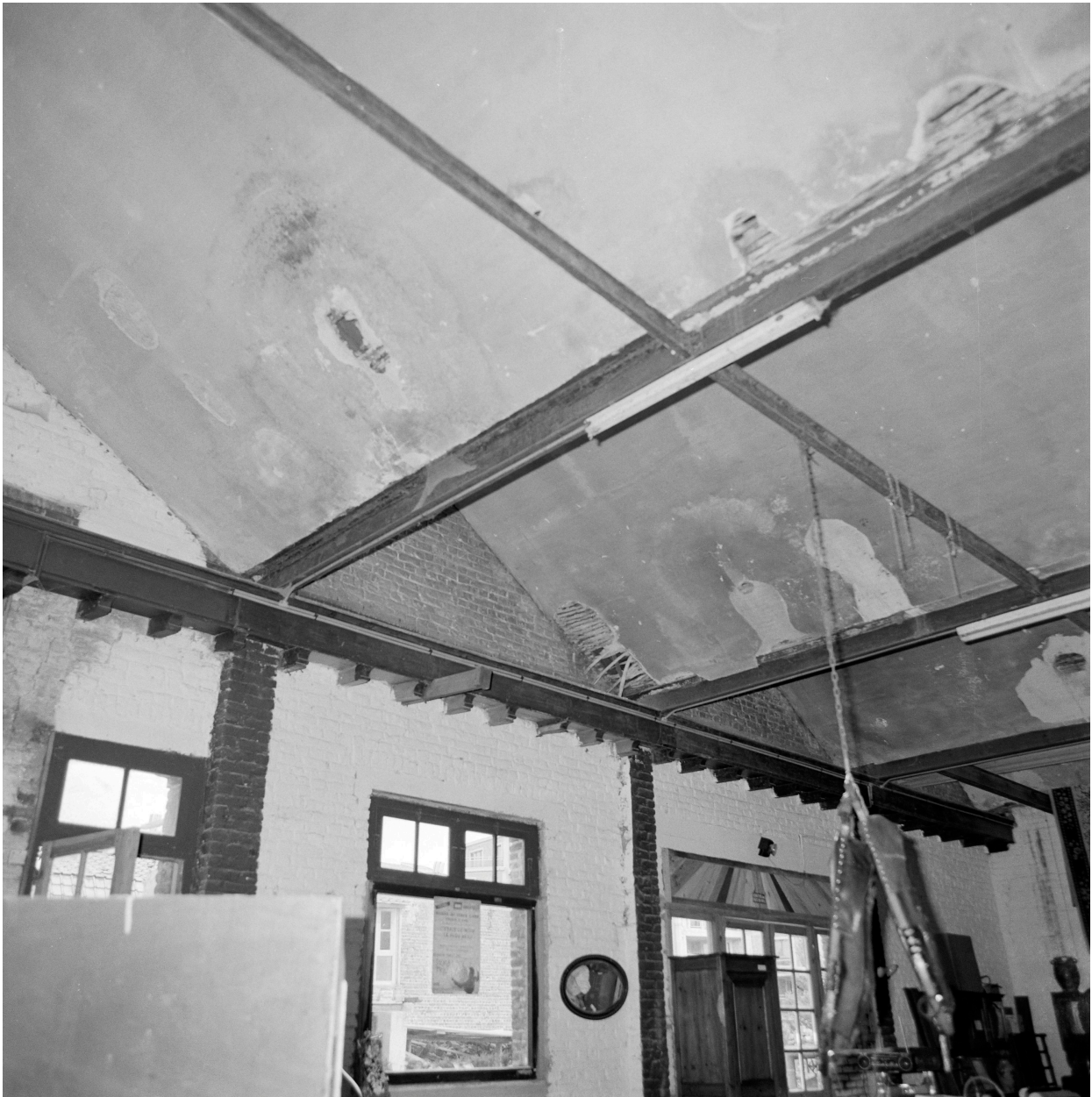
Atelier de fabrication. Chéneau intérieur.
