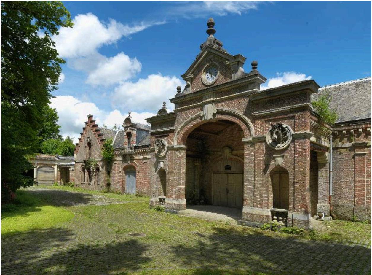
Les communs, vue extérieure des écuries.
