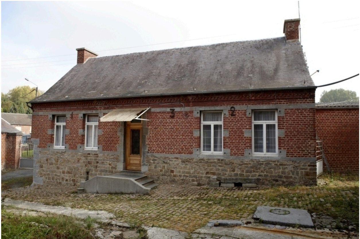
Vue générale du logis, depuis la cour.
