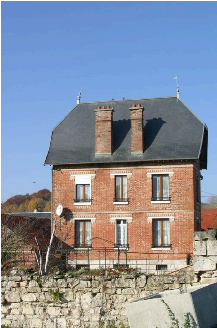
Vue générale de la façade postérieure.
