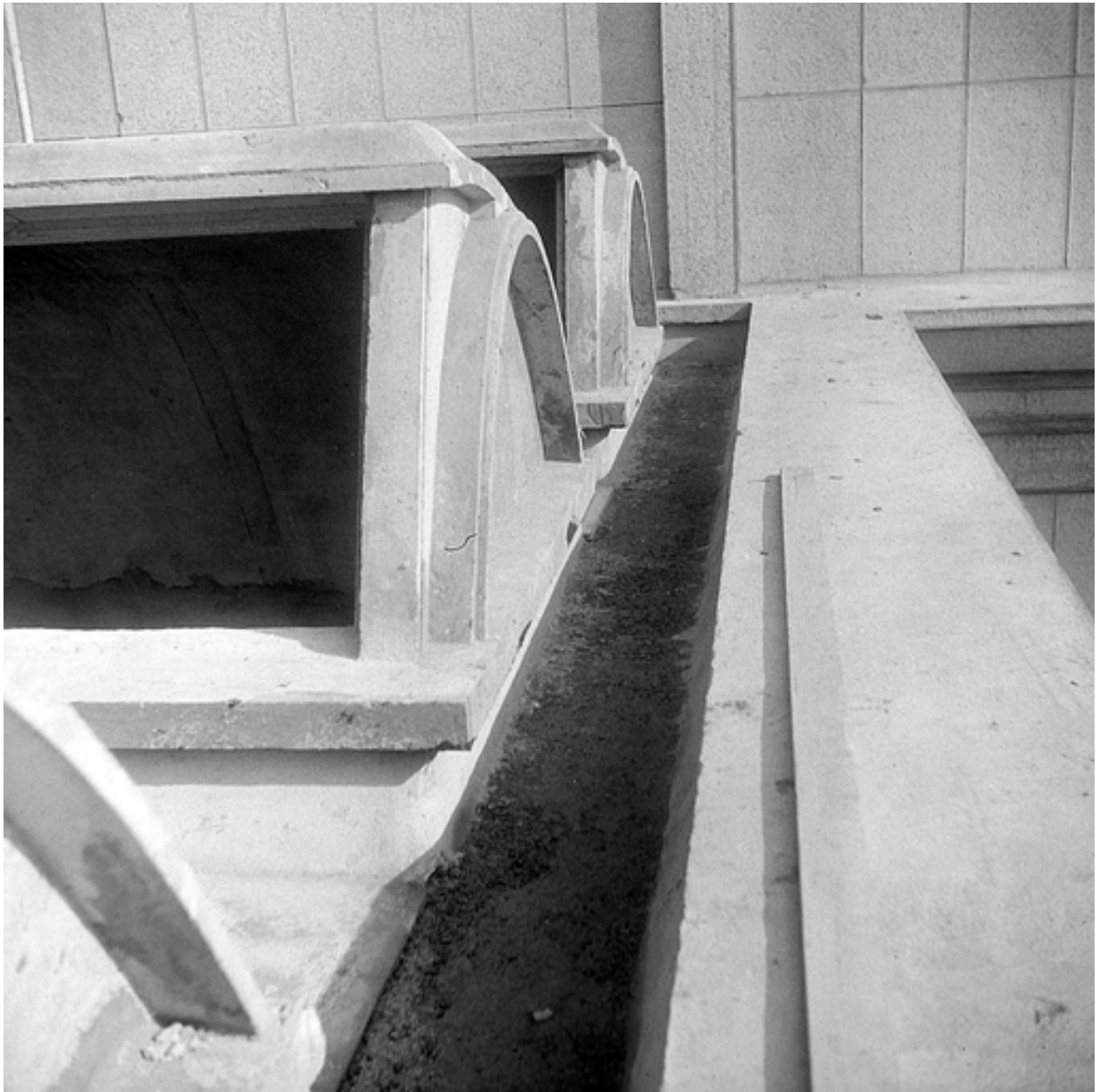
Les sheds des services généraux, vers 1950 (IFA).
