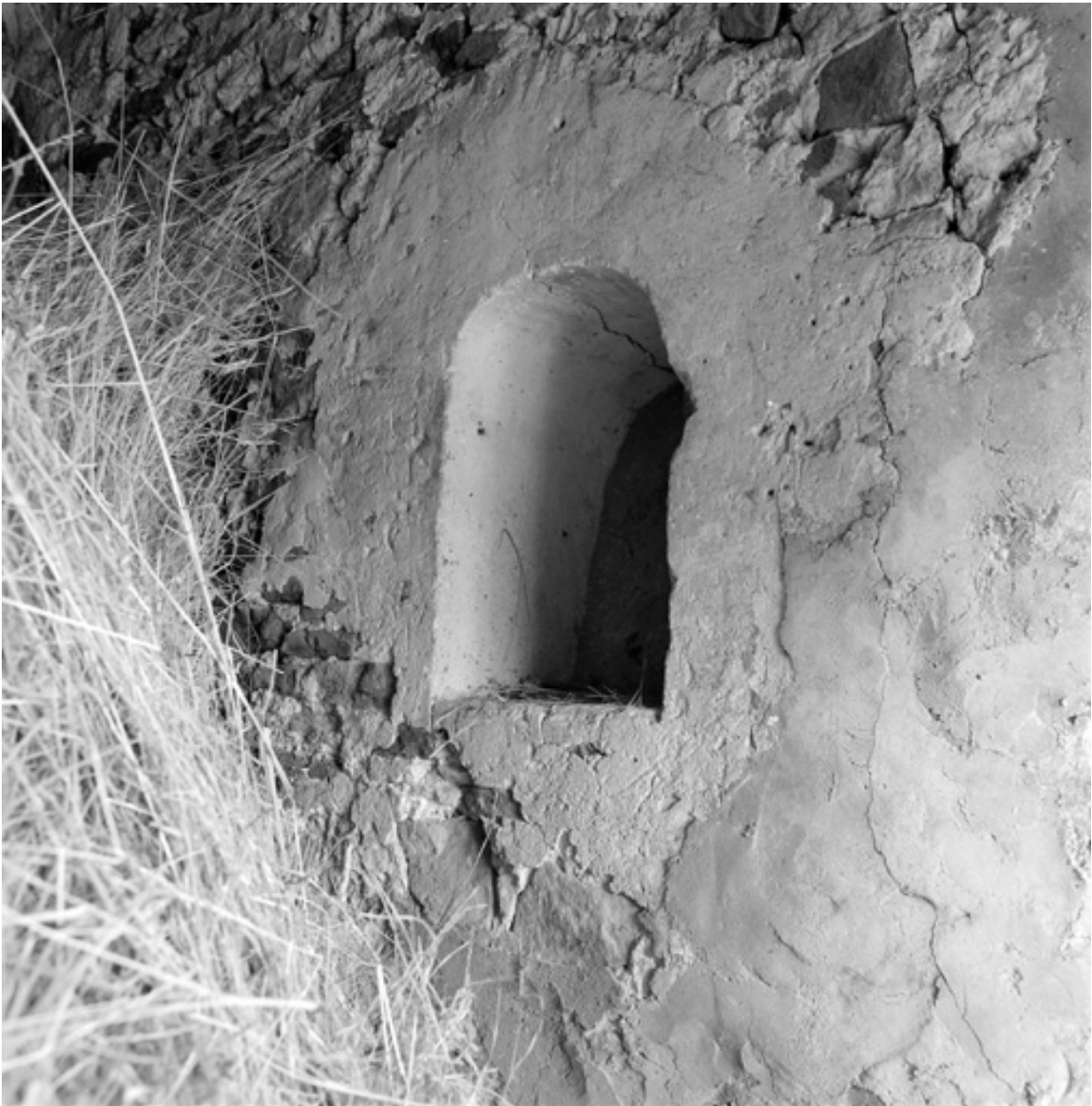
Baie condamnée dans le mur nord du rez-de-chaussée.
