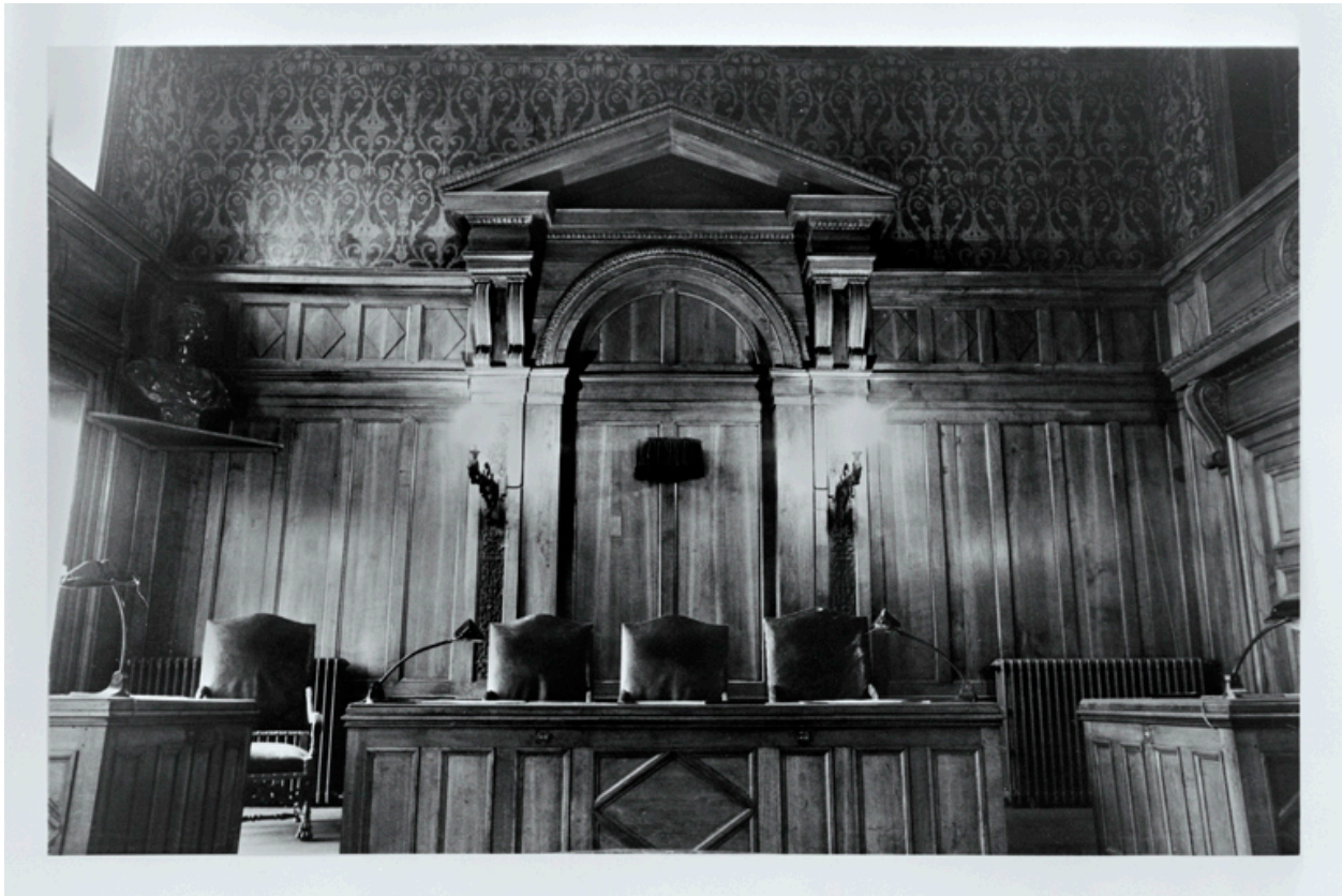
Détail de la tribune et des boiseries de la salle d'audience en 1976 (cliché CRMH).
