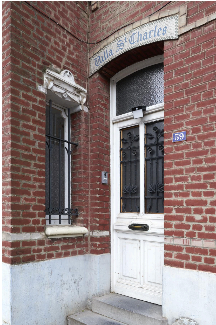
Porte d'entrée sur rue.
