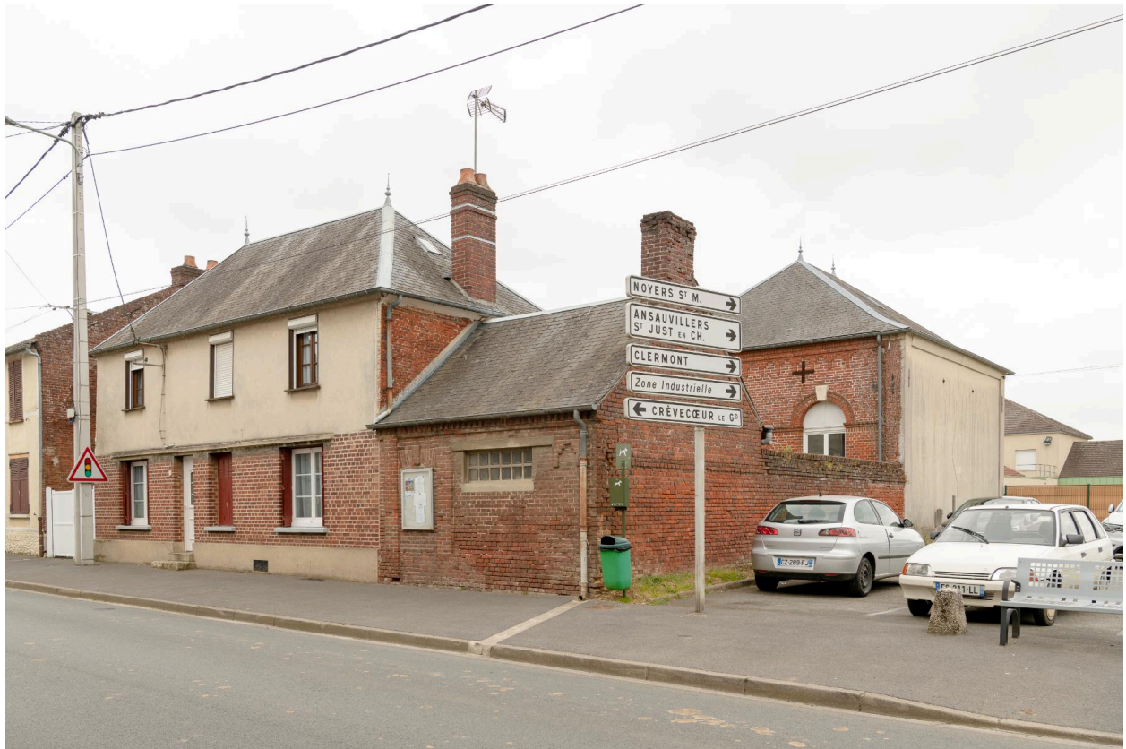
Ancienne école de filles, n°19 rue de Beauvais, vue depuis le nord-ouest.
