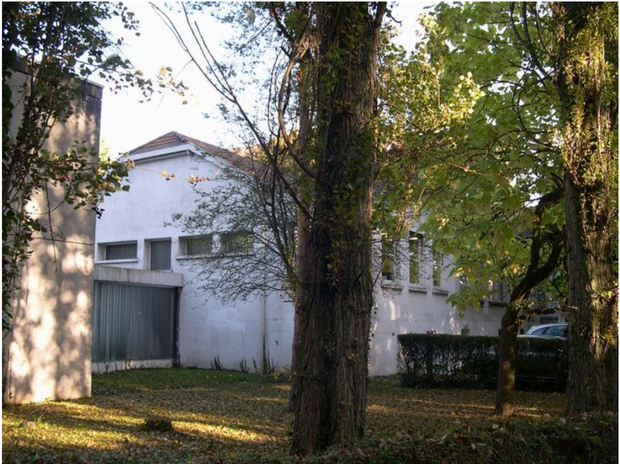
Ancienne salle des lavabos, façade est, vue depuis le sud-est.
