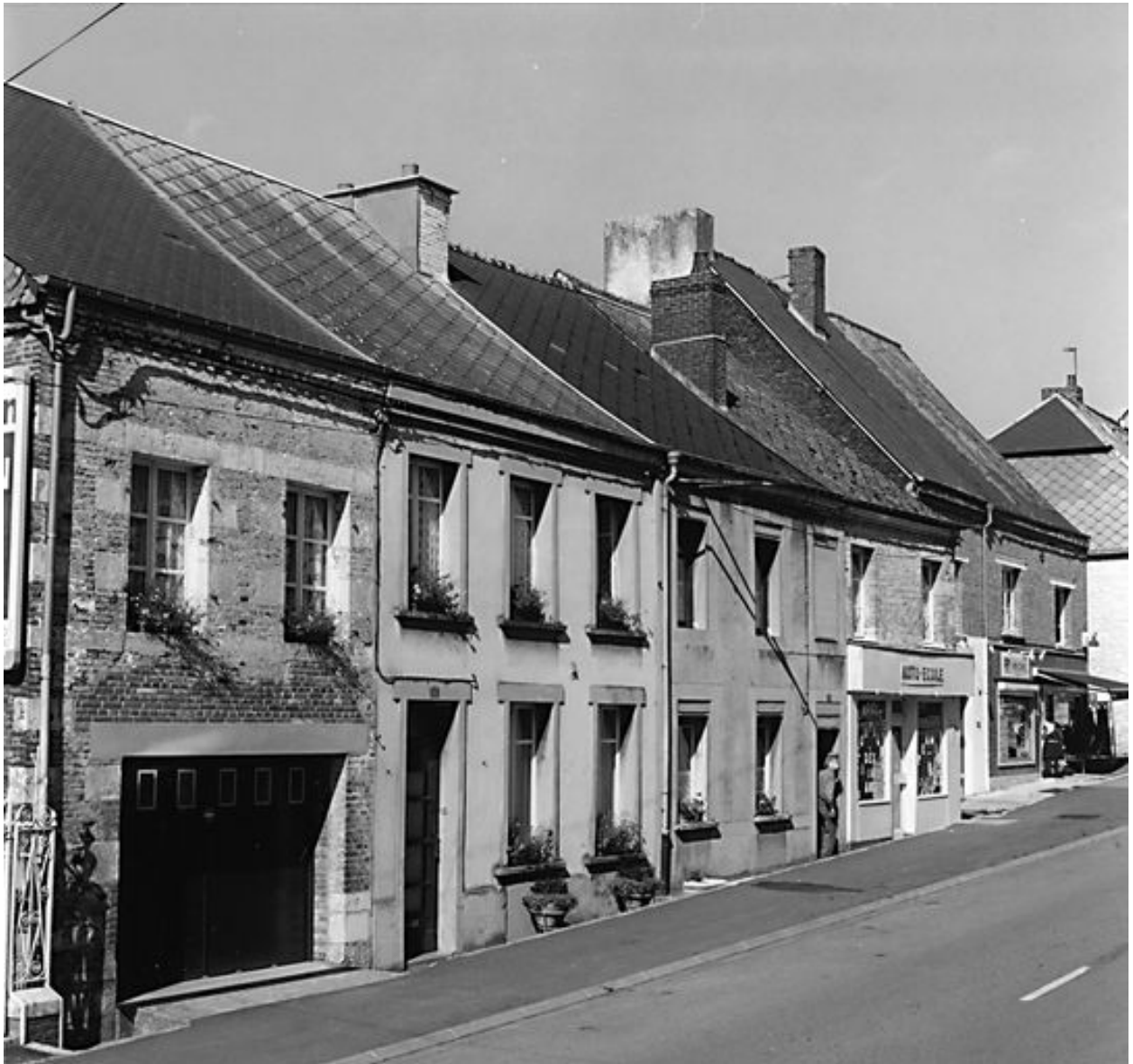
Vue des quatre maisons réoccupant le collège.
