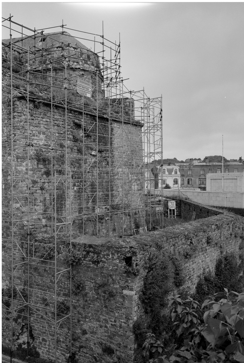
Façade sud partielle en cours de restauration.
