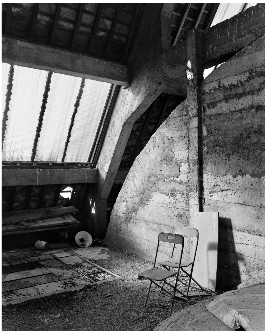
Niveau des combles : accès au plafond vitré de la salle de bal.
