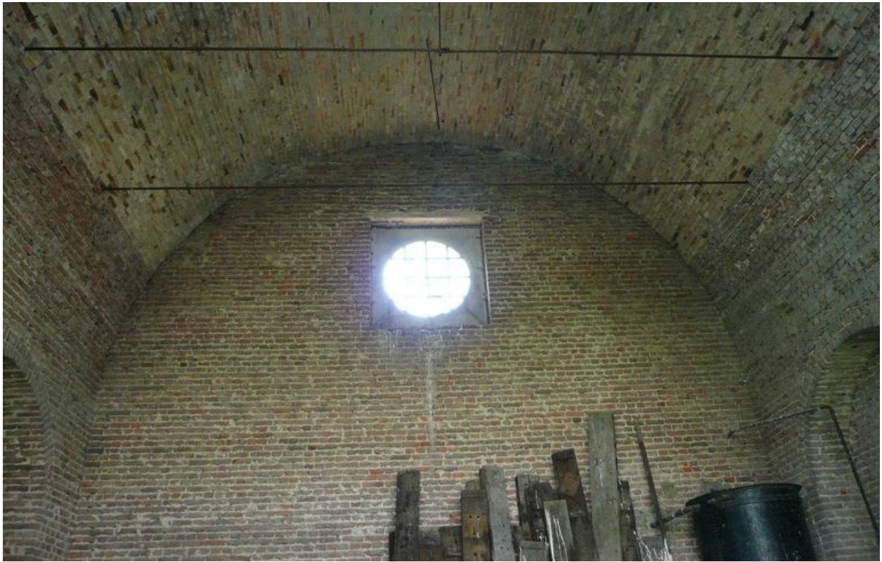
Vue intérieure de la chapelle.
