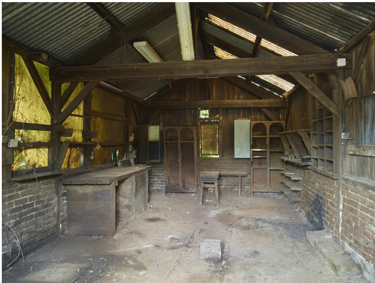
Vue intérieure de l'atelier de réparation.
