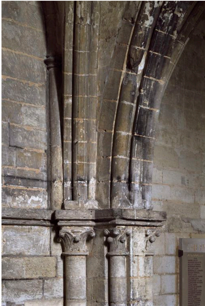
Chapiteaux et arcs du rez-de-chaussée du clocher-porche.
