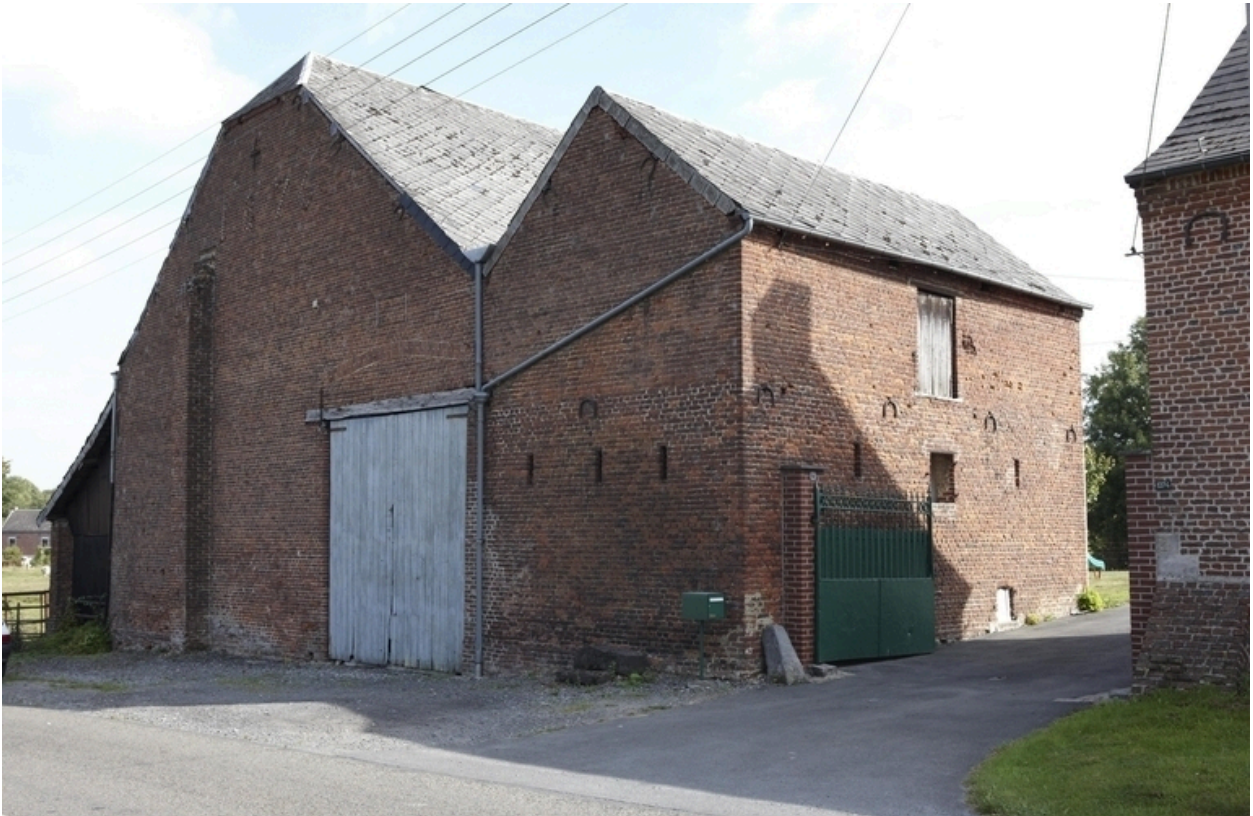
Vue de la grange et d'une remise depuis la voie.
