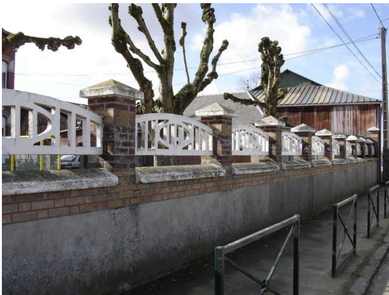
Vue de la clôture d'enceinte.
