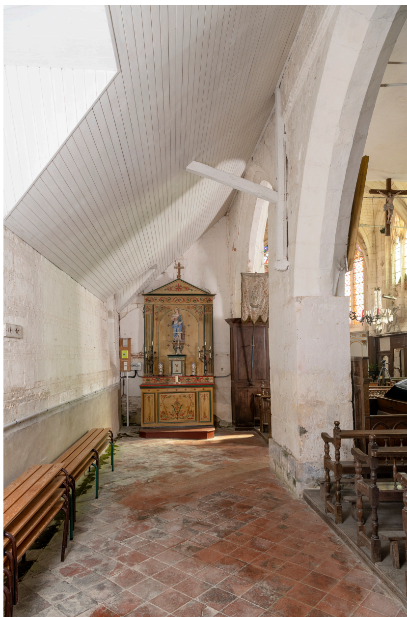
Vue générale du bas-côté nord.
