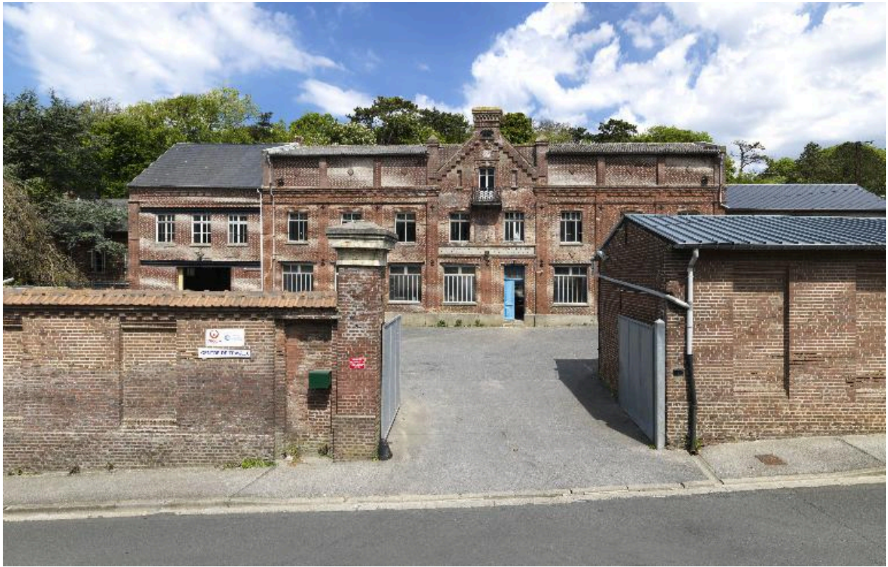
Vue générale depuis la rue du Général-Leclerc.
