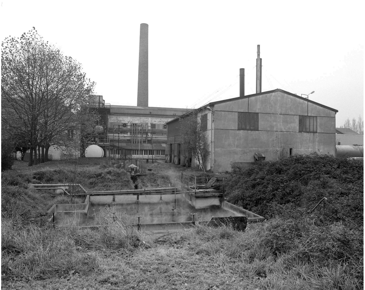
Atelier de fabrication. Vue prise vers le sud.
