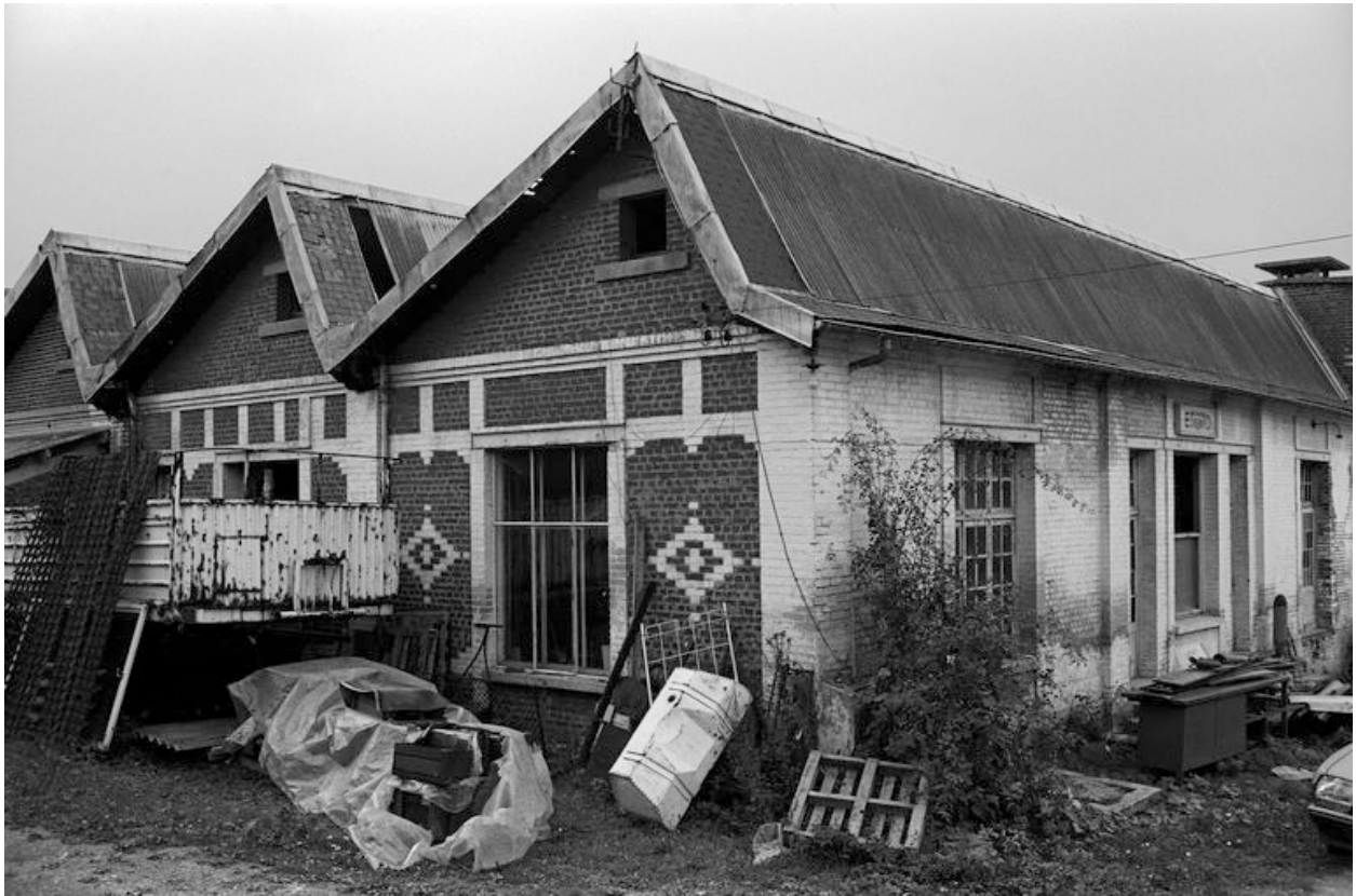
Atelier de fabrication, flanc nord-est.
