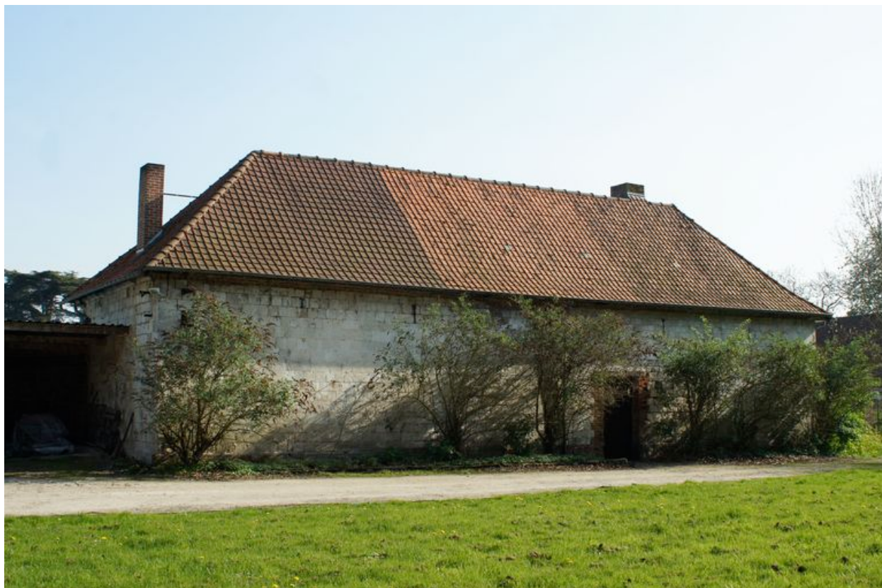
Elévation postérieure du bâtiment du potager.
