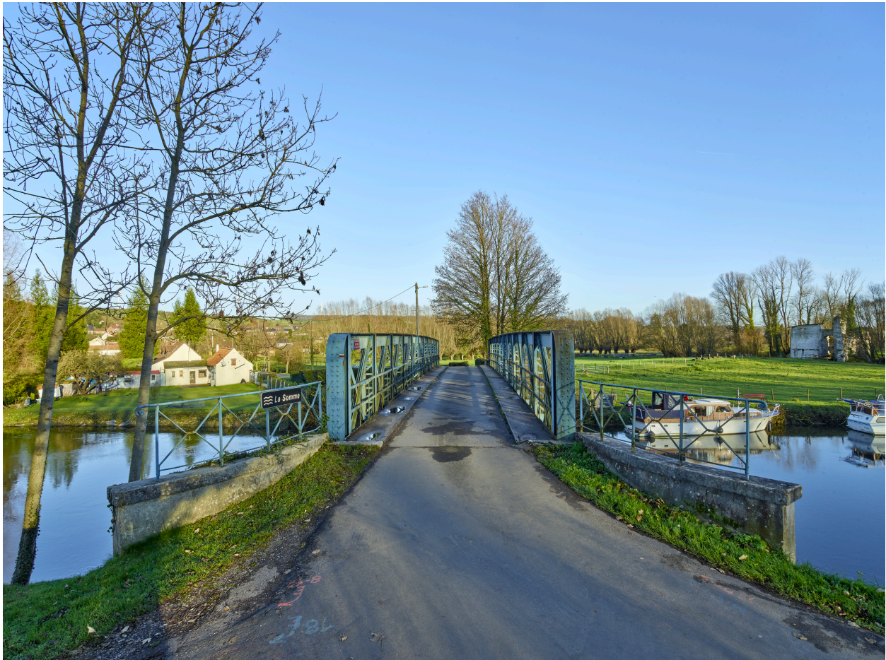
Vue du pont, depuis la rive gauche de la Somme.
