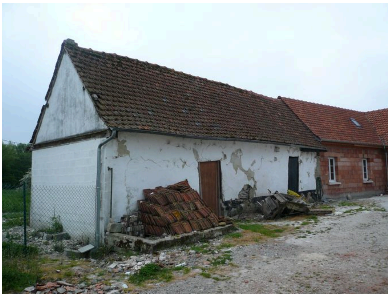
Vue de la grange-étables perpendiculaire au logis.
