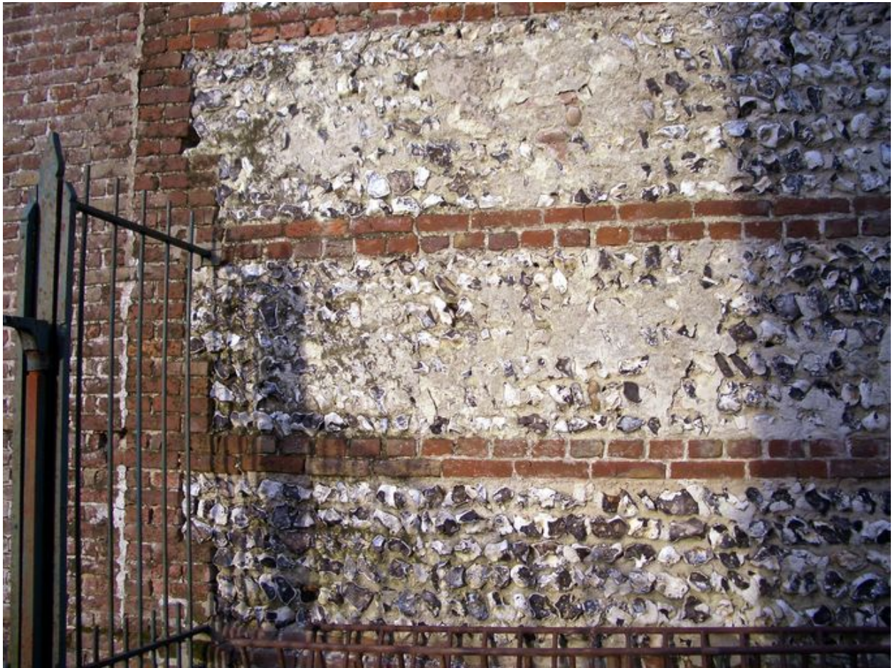
Détail de l'appareillage du pigeonnier.
