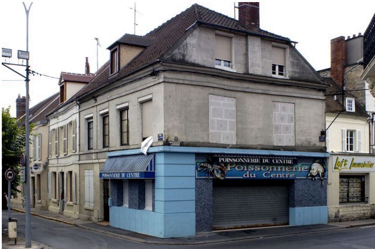
Vue d'ensemble de l'ancienne carderie.
