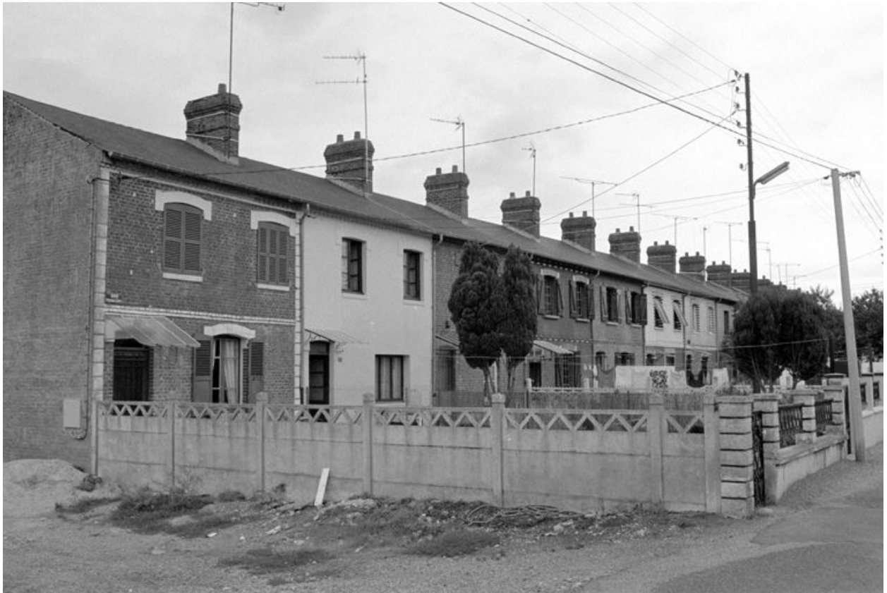
Logement d'ouvriers, vue partielle.
