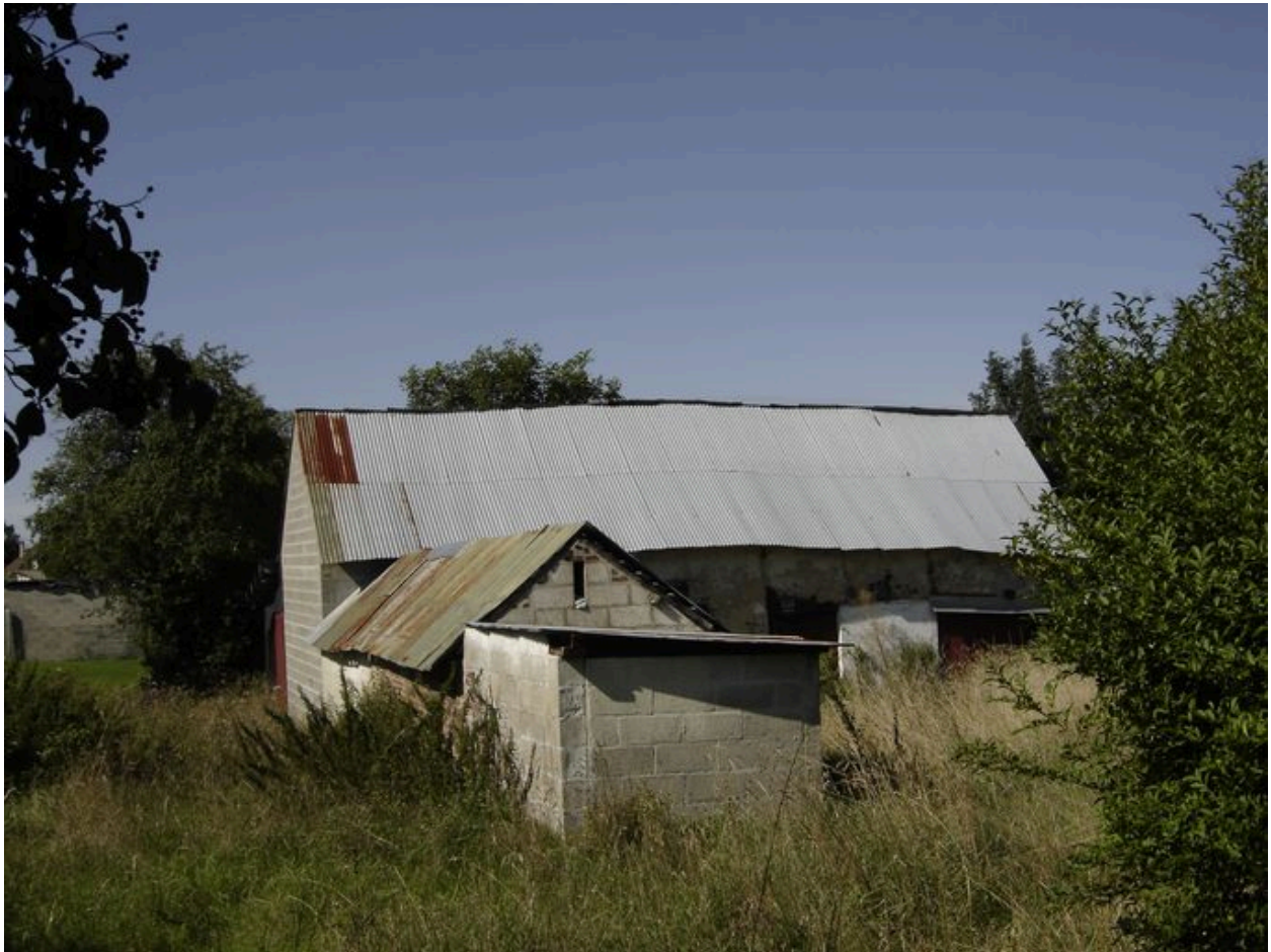
Vue de la grange en fond de cour.
