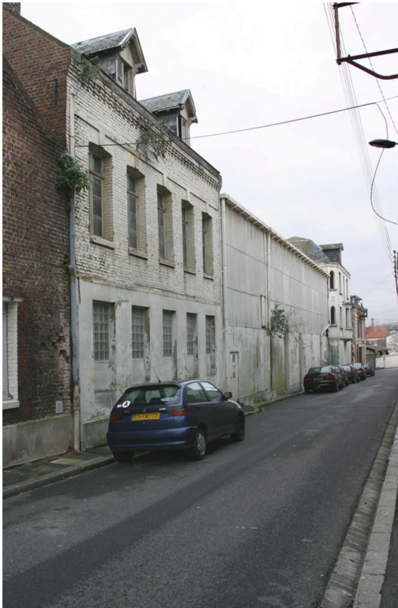
Le site vu depuis la rue de Bagatelle.
