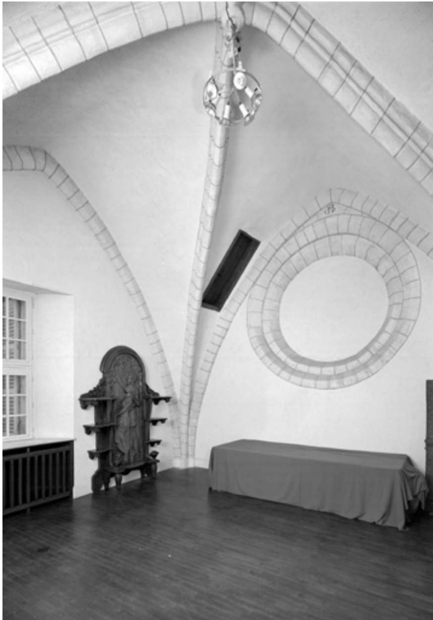
Le voûtement de la première travée.
